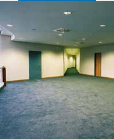
Pose de moquette dans la zone d'accueil d'un établissement sportif - Palazzetto Del Ghiaccio Allemagne.
