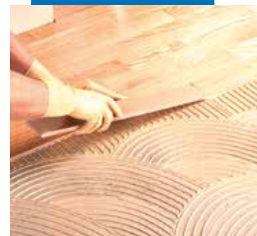
Pose du parquet
