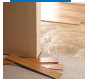
Application de la colle
