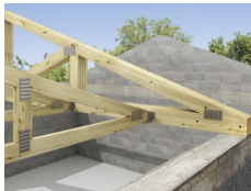
Assemblage des fermettes
