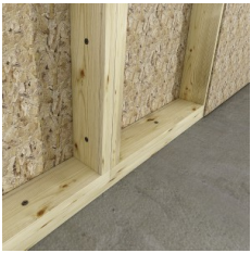
Doublage de montants
