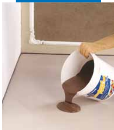
Versement du mélange obtenu sur la chape
