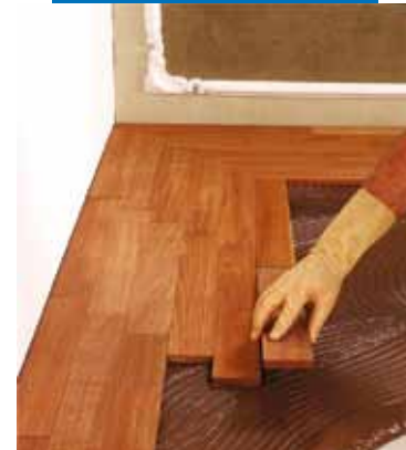
Pose d'un parquet en teck massif (14 mm)
