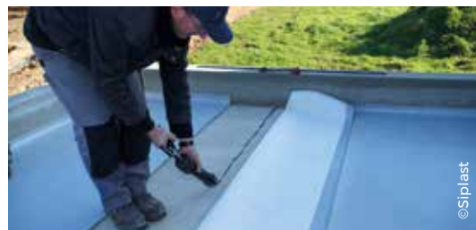
Auto-collage à froid de membranes bitumeuses
