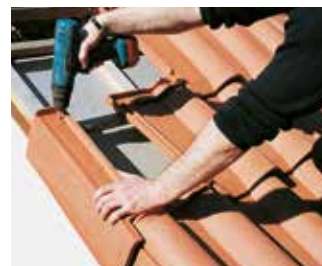
Rive individuelle : principe de pose
