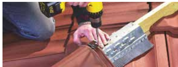
Pose à emboîtement fixé à sec
