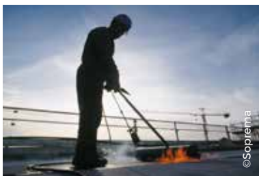
Soudure au chalumeau de membranes bitumeuses
