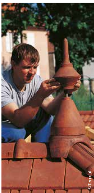
Poinçon 3 éléments
