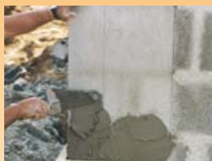
Encollage du mur
